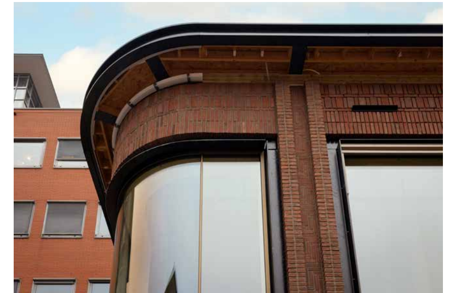
De imposante ruiten zijn met speciaal transport naar de projectlocatie in Amstelveen vervoerd.
