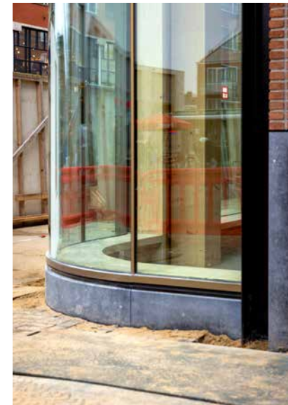
Het gebogen glas is gemaakt in elektrische ovens waarmee de temperatuur van het buigproces heel goed gereguleerd kan worden.
