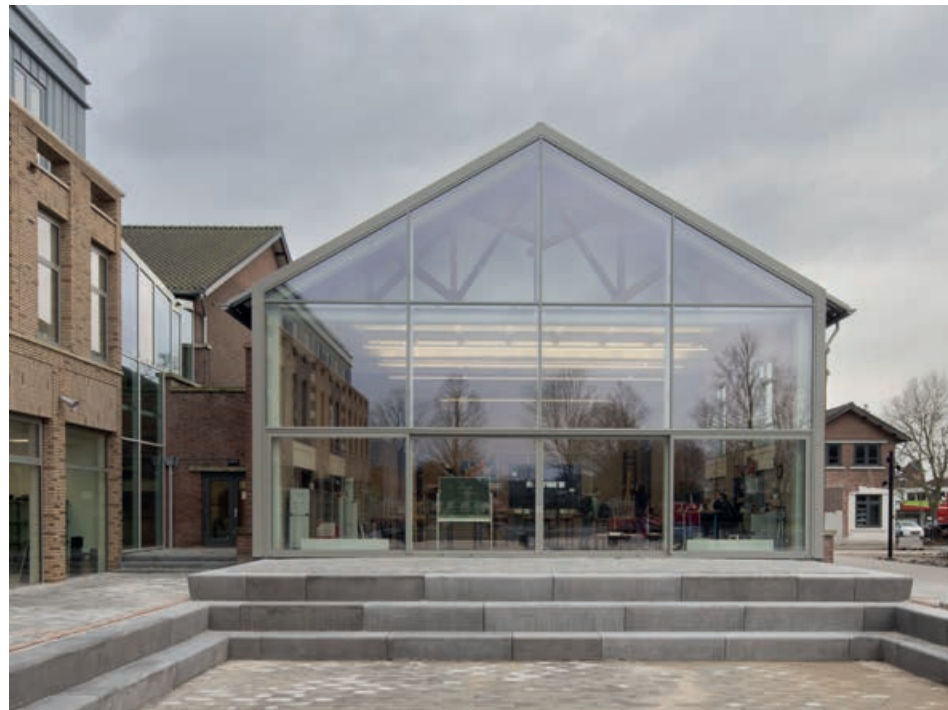
Voor de transparante kopgevel leverde Vandaglas glaspuien van ruim 3 meter hoog en breed
