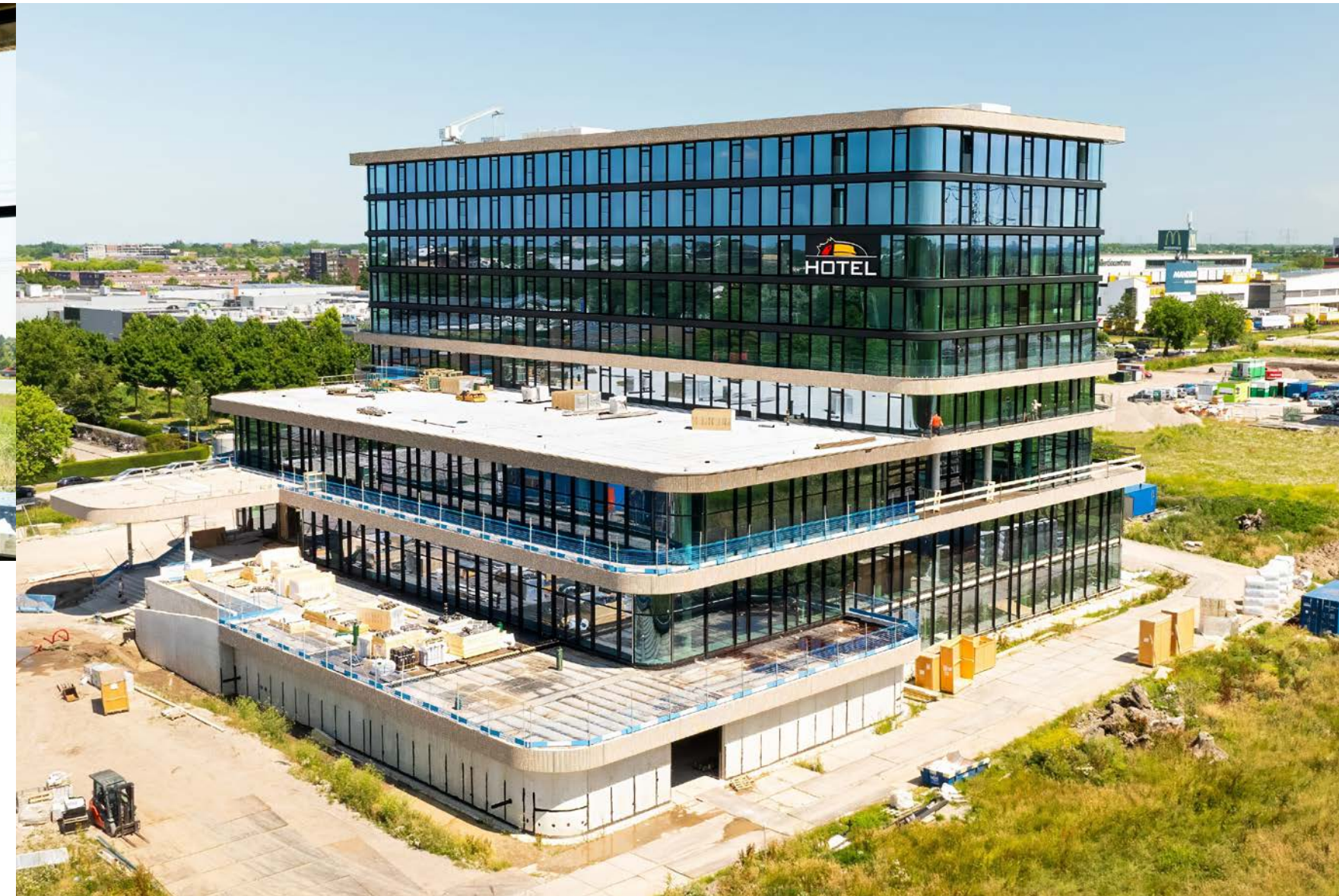
Omdat het complete project in TriplePerform SKN 154 is uitgevoerd, is er geen optisch verschil tussen de rechte en gebogen ruiten.
