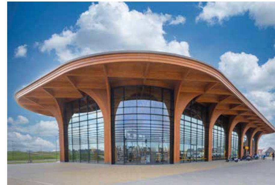
Superhub Meerstad, volglazen gevels met gebogen isolatieglas.
