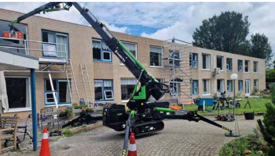
Nieuwe beglazing Woonzorgcentrum Gockingaheem Noordbroek.
