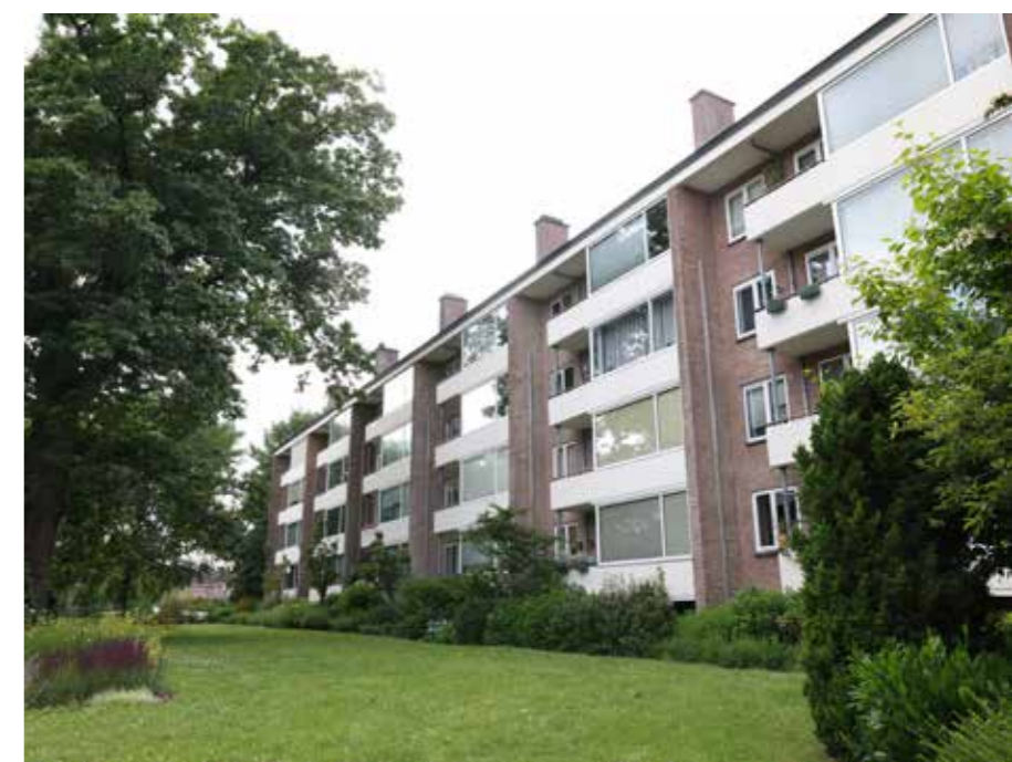
Nieuwe beglazing appartementen VVE Saturnusstraat Apeldoorn..
