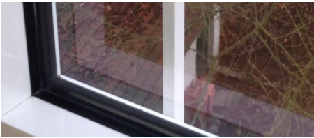
De matzwarte Warm-Edge Spacer valt niet op in tegenstelling tot de aluminium afstandhouder die bij veel zon hinderlijk kan reflecteren.
