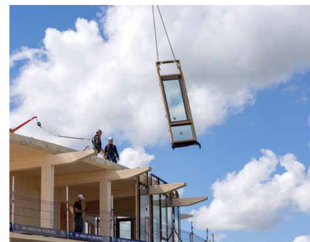
Montage van het isolatieglas.
