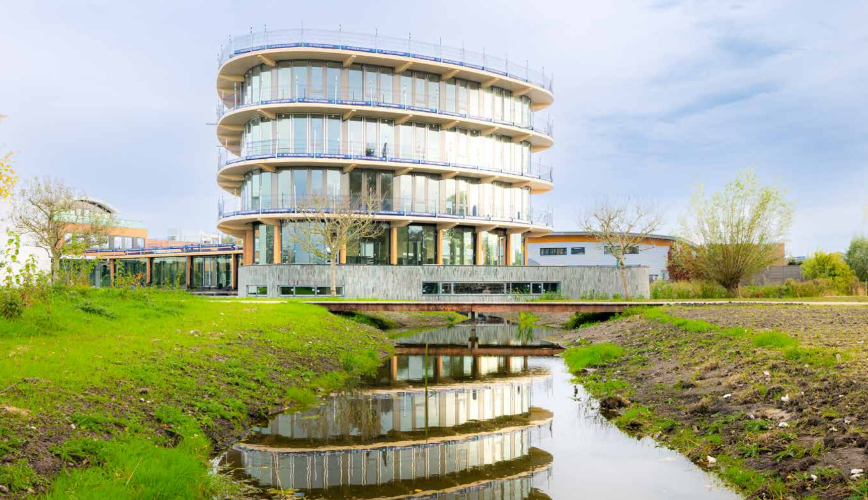
Parel in de Polder is het eerste project in Nederland waarin Low Carbon isolatieglas IsoPerform LCG XTR70/33 ORAE wordt toegepast.
