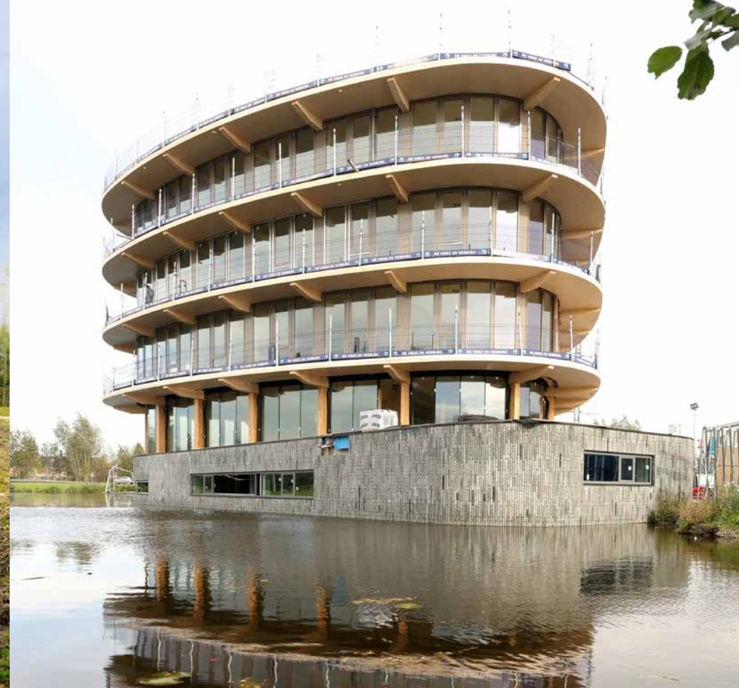
Het IsoPerform LCG XTR70/33 ORAE isolatieglas van Vandaglas garandeert uitstekende thermische prestaties, een hoge energie-efficiëntie en een comfortabel binnenklimaat in Parel in de Polder.
