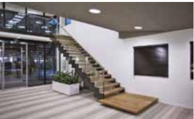
De trapbomen van deze trap zijn van staal, maar de bamboe treden bepalen de uitstraling.
