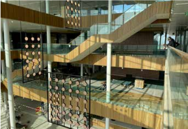
De trapbomen van deze trap zijn van staal, maar de bamboe treden bepalen de uitstraling.
