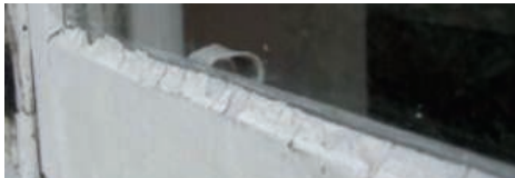
Stopverf met asbest valt in risicoklasse 2
